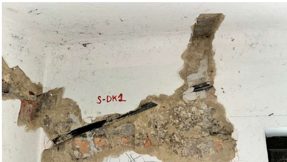
Foto 47: Pohled na provedenou sondu S-DK2. Překlad je součástí železobetonového věnce.
