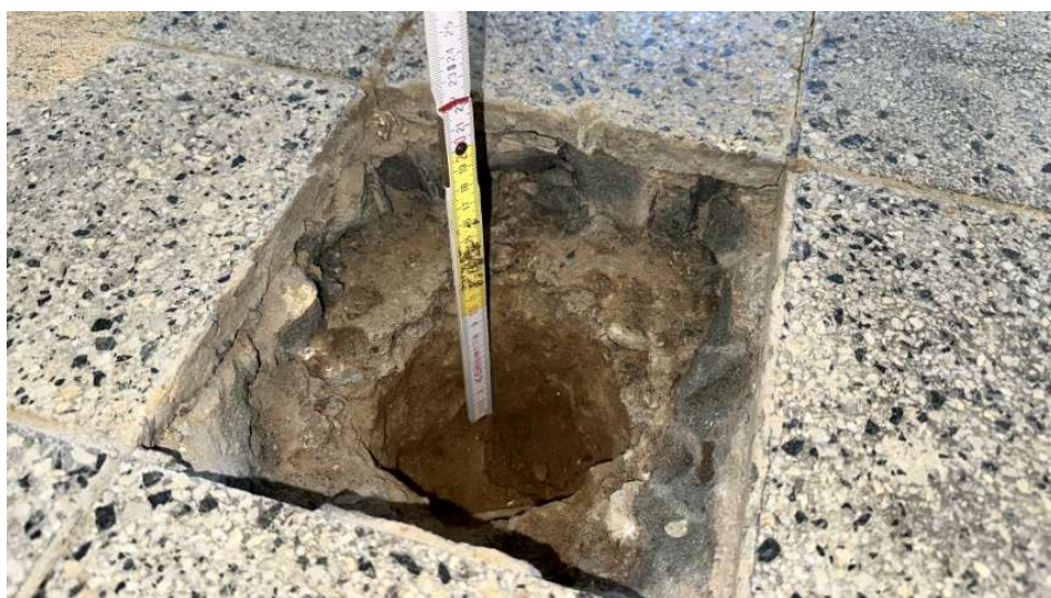
Foto 9: Pohled na provedenou sondu S-P3.
