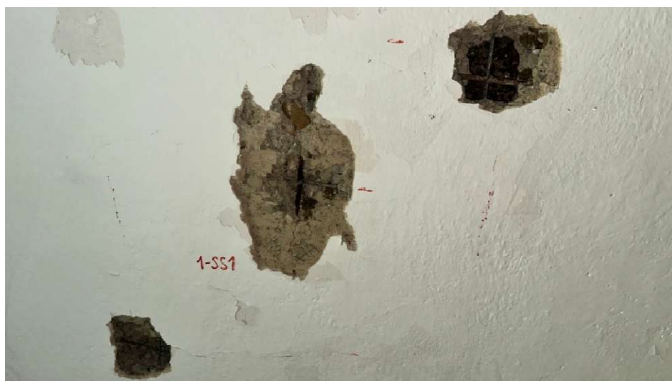
Foto 38: Pohled na provedenou sondu 1-SS1.
