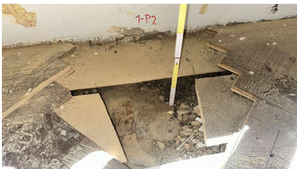
Foto 13: Pohled na provedenou sondu 1-P2.
