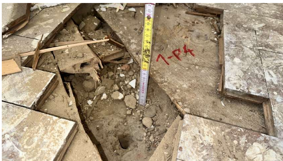
Foto 18: Pohled na provedenou sondu 1-P4.
