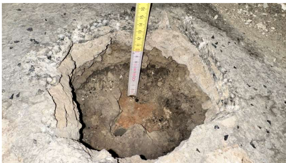
Foto 11: Pohled na provedenou sondu 1-P1.
