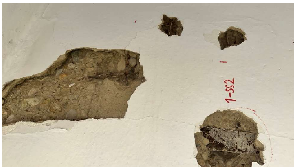
Foto 41: Pohled na provedenou sondu 1-SS2.
