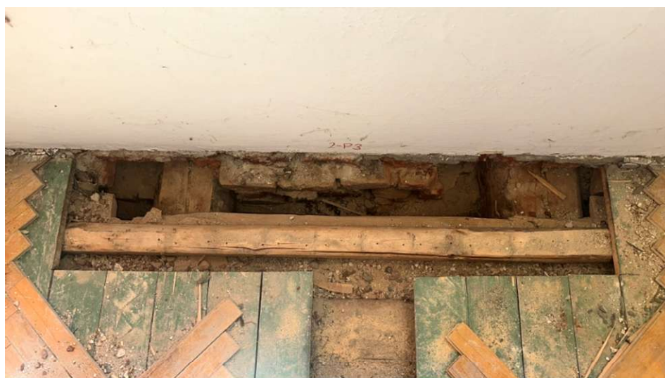
Foto 25: Pohled na provedenou sondu 2-P3.
