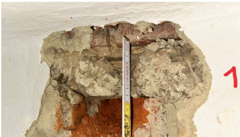
Foto 52: Pohled na obnaženou konstrukci věnce výšky 90 mm.
