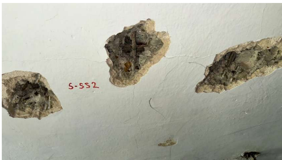
Foto 33: Pohled na provedenou sondu S-SS2.
