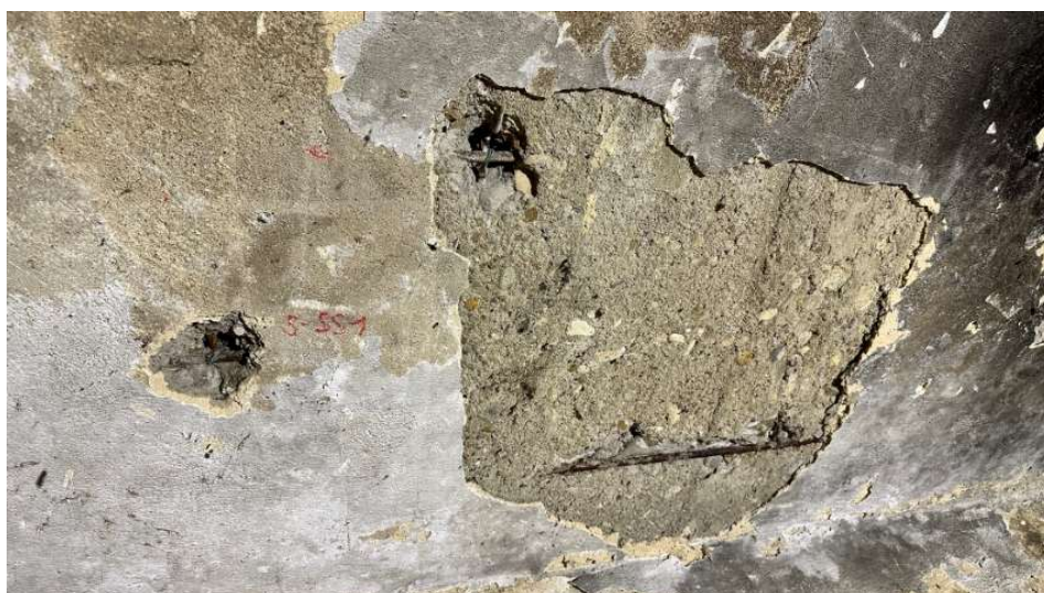
Foto 31: Pohled na provedenou sondu 1-SS1.
