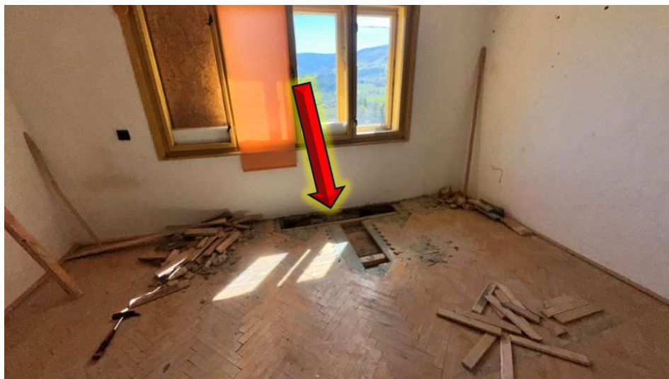
Foto 24: Pohled na místo sondy 2-P3.
