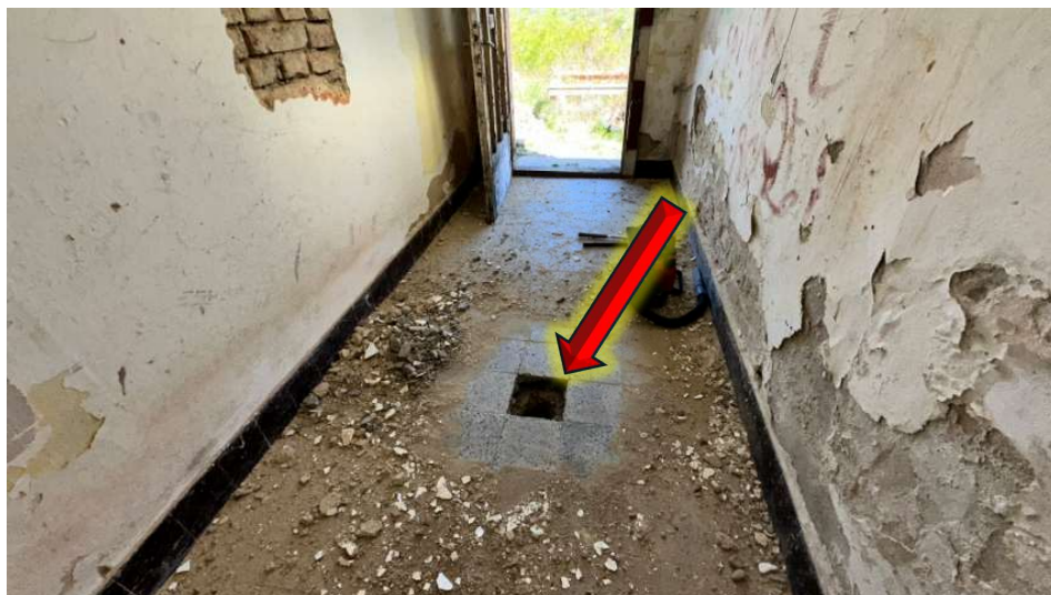
Foto 8: Pohled na místo sondy S-P3.
