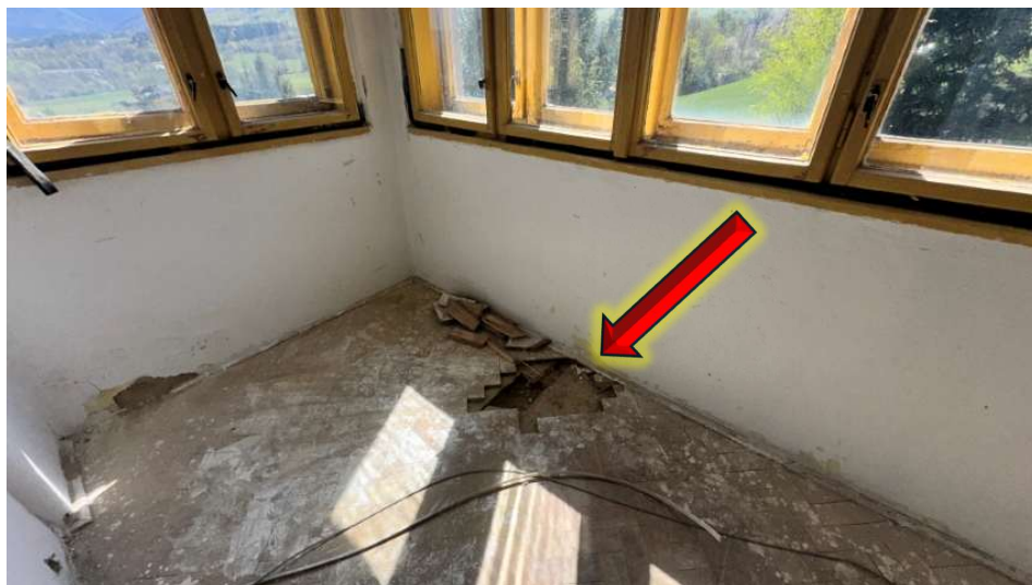
Foto 17: Pohled na místo sondy 1-P4.
