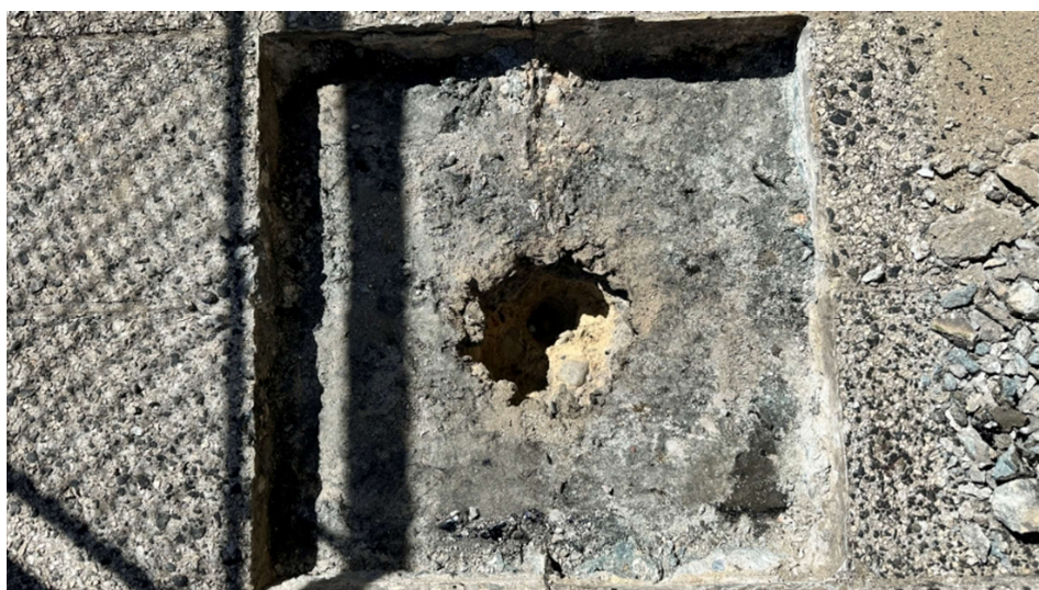
Foto 28: Pohled na provedenou sondu S1.
