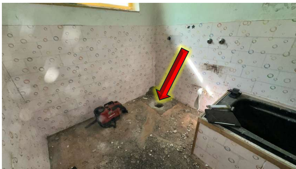
Foto 10: Pohled na místo sondy 1-P1.
