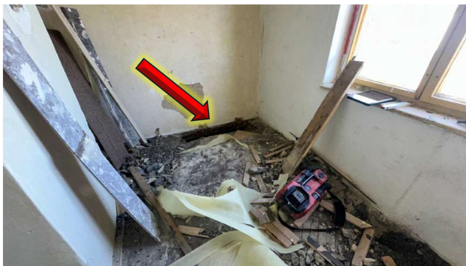
Foto 19: Pohled na místo sondy 2-P1.
