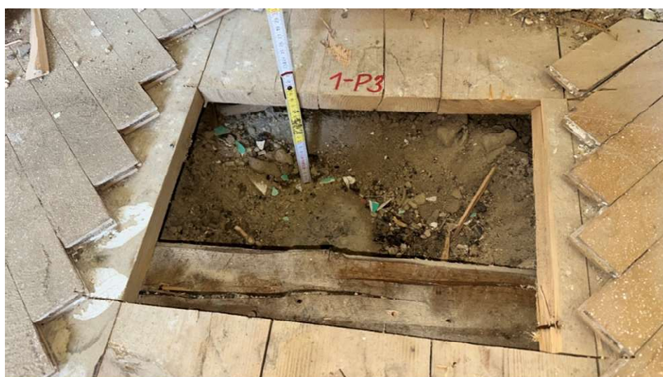
Foto 16: Pohled na provedenou sondu 1-P3.
