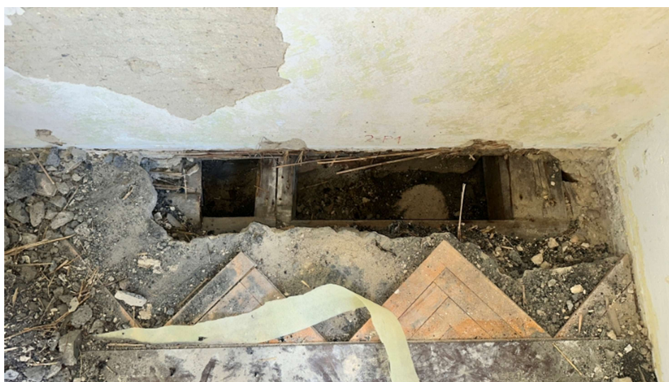
Foto 20: Pohled na provedenou sondu 2-P1.
