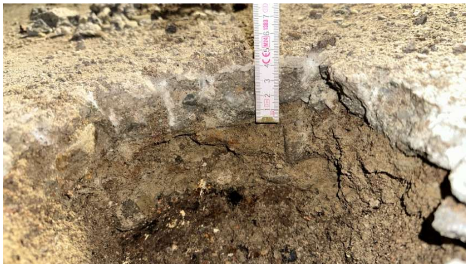
Foto 5: Pohled na provedenou sondu S-P1. Tloušťka betonové mazaniny 45 mm.
