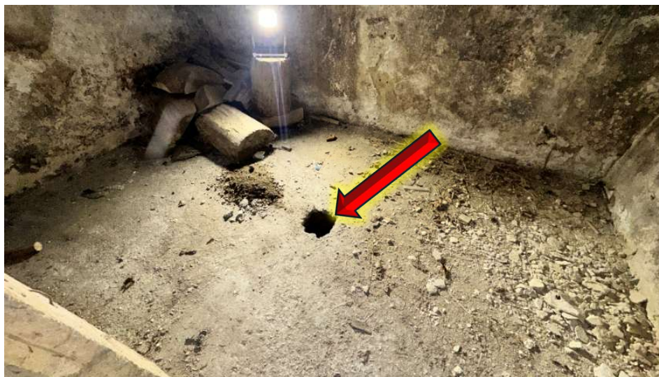
Foto 4: Pohled na místo sondy S-P1.
