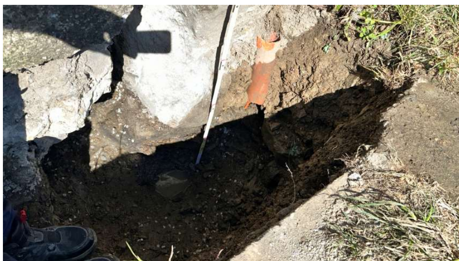
Foto 2: Pohled na místo kopané sondy K1, základová spára v úrovni cca 600-700 mm pod úrovní přilehlého terénu.
