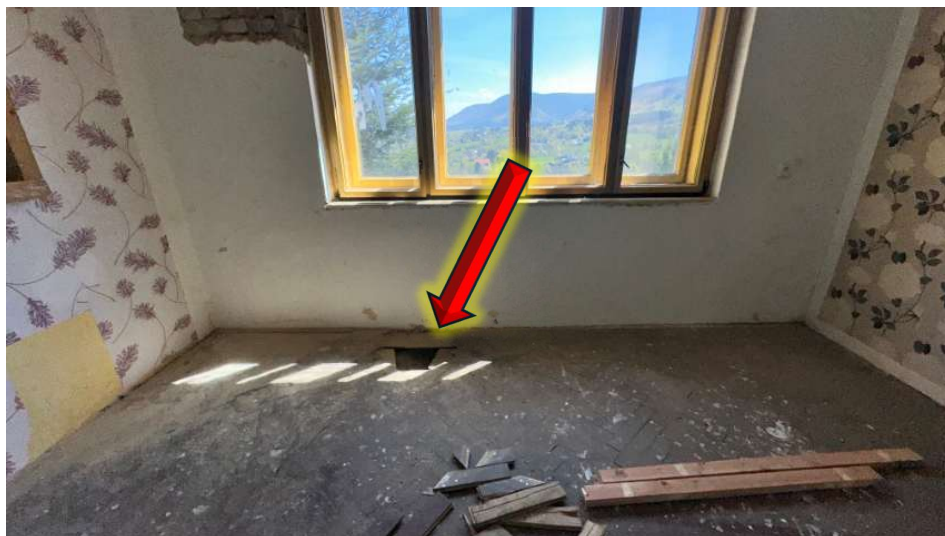
Foto 12: Pohled na místo sondy 1-P2.
