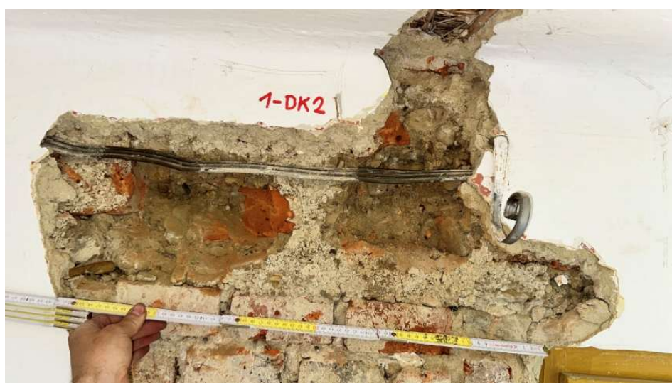
Foto 55: Přibližně do vzdálenosti 300 mm od hrany ostění je věnec proveden v celé šířce zdiva. Dále je věnec zúžen o přizdívku z cihel plných pálených uložených "na kant".
