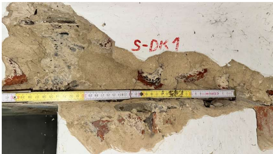
Foto 45: Pohled na uložení profilů IPN na zděný pilíř. Profily uloženy do maltového lože. Délka uložení profilů cca 340 mm.
