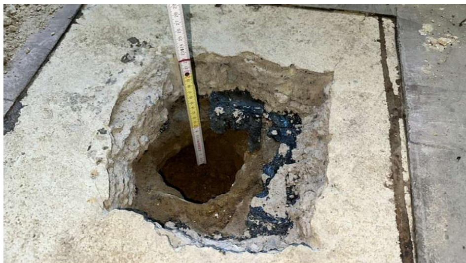
Foto 7: Pohled na provedenou sondu S-P2.
