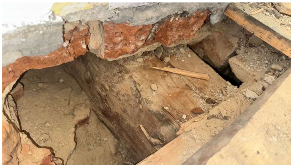
Foto 26: Pohled na uložení nosných dřevěných trámů, bez zjevného biotického napadení.
