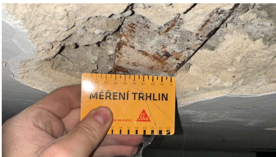
Foto 34: Pohled na vychýlení profilů IPN 120 od svislé osy.
