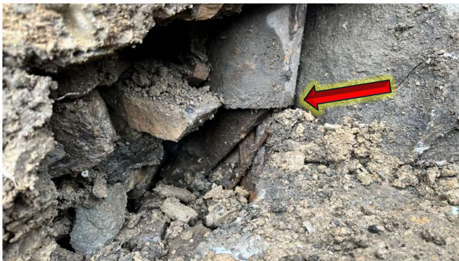
Foto 60: Pohled na vyústění střešního svodu přímo k základové konstrukci.
