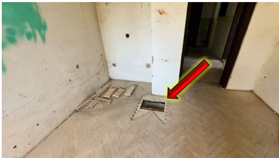
Foto 15: Pohled na místo sondy 1-P3.
