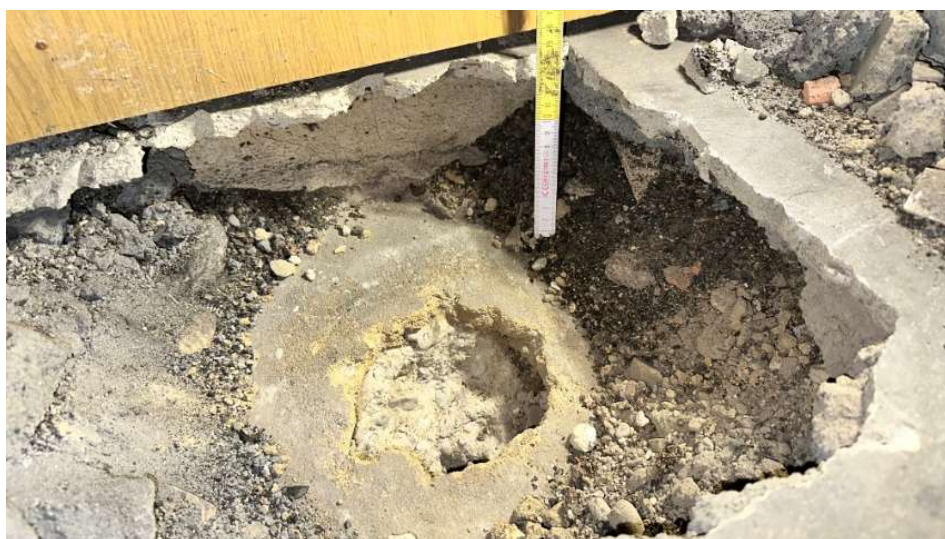
Foto 23: Pohled na provedenou sondu 2-P2.
