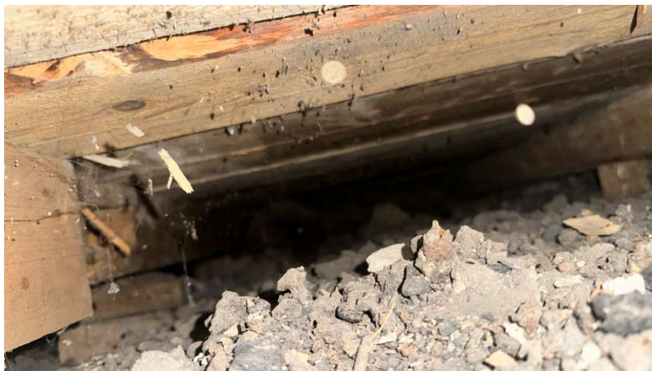
Foto 21: Pohled na nosnou konstrukci podlahy nad ŽB stropem nad koupelnou, na ŽB desce vrstva násypu.
