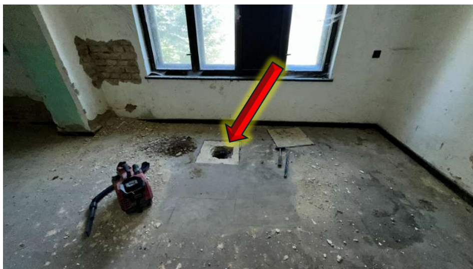
Foto 6: Pohled na místo sondy S-P2.
