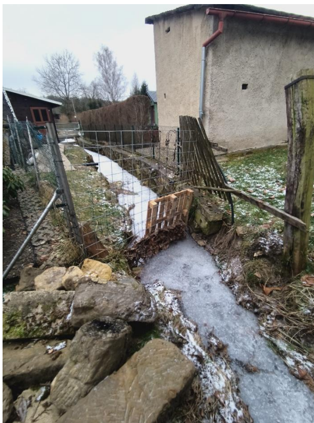
Pohled po toku na stávající opěrné zídky
