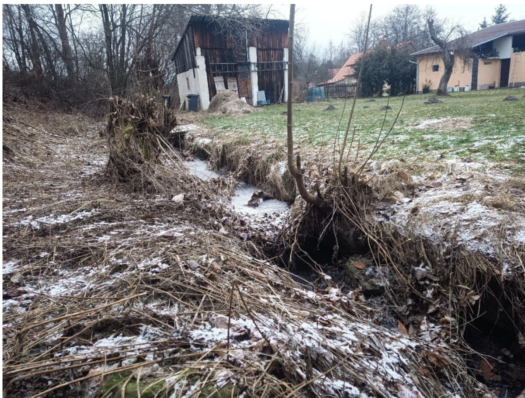
Pohled na zazemněné koryto
