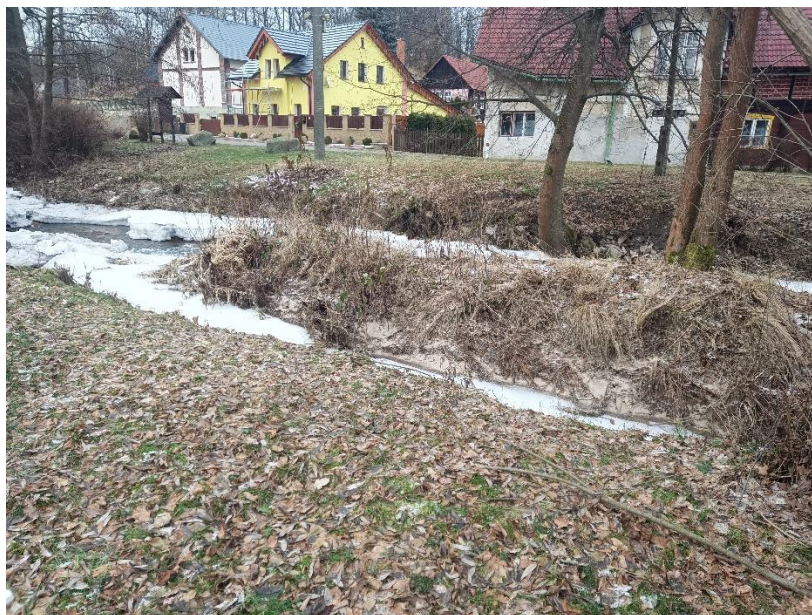
Pohled proti toku na konec úseku
