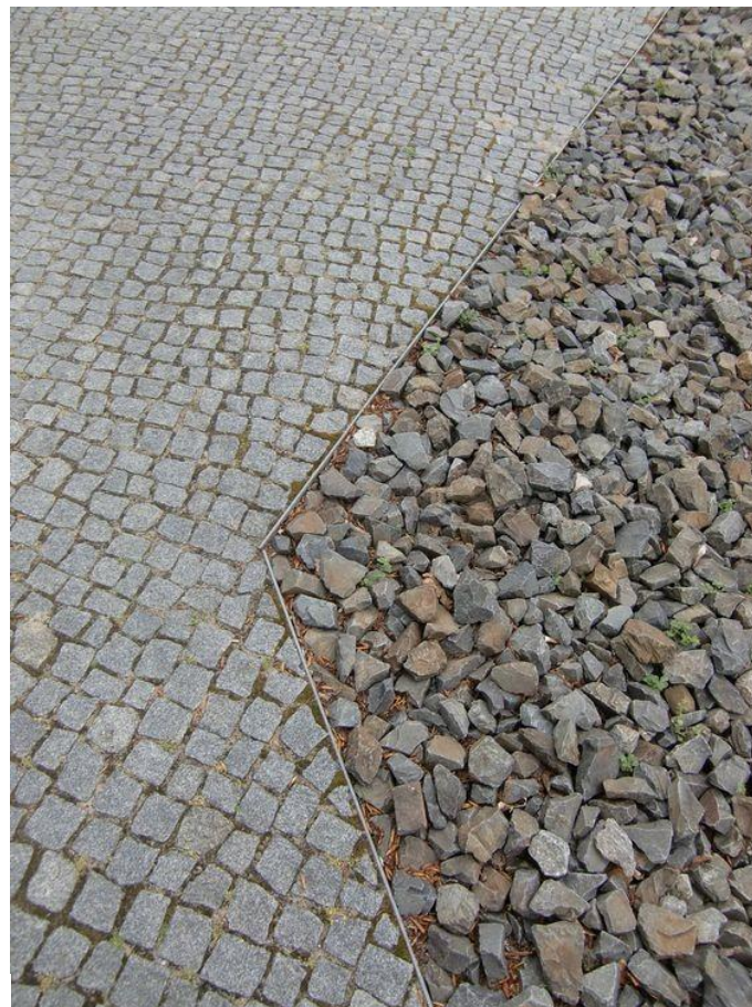
detail styku materiálu A a štěrku - Slezská světlá žula, štěrk frakce 33/62
