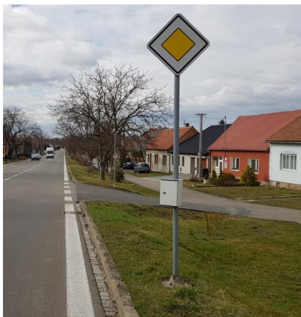
Ilustrativní foto montáže přístroje na měření intenzity dopravy:
